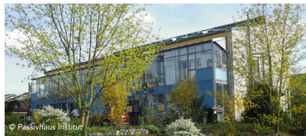
Erstes Passivhaus, Darmstadt Gemessener Heizwärmeverbrauch 1992-2016 Mittelwert: 8,4 kWh / (m²a)
