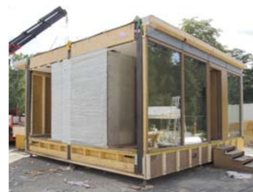
Das Haus kann in gleich große Raummodule zerlegt werden. Die einzelnen Module sind auf Transportmaß
